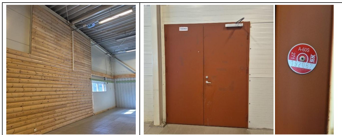
Figur 2 viser bilder trepanel og brannndør
